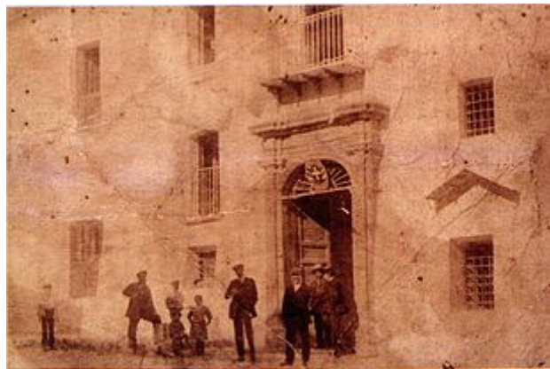
Il Palazzo Ducale di Bivona in una foto di inizio Novecento
